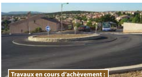
Travaux en cours d'achèvement : rue des Pattes (espaces verts) et le giratoire hauts de Fontcaude (espaces verts,abri-bus).
