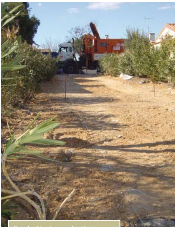
Rue des Uranies pendant les travaux
