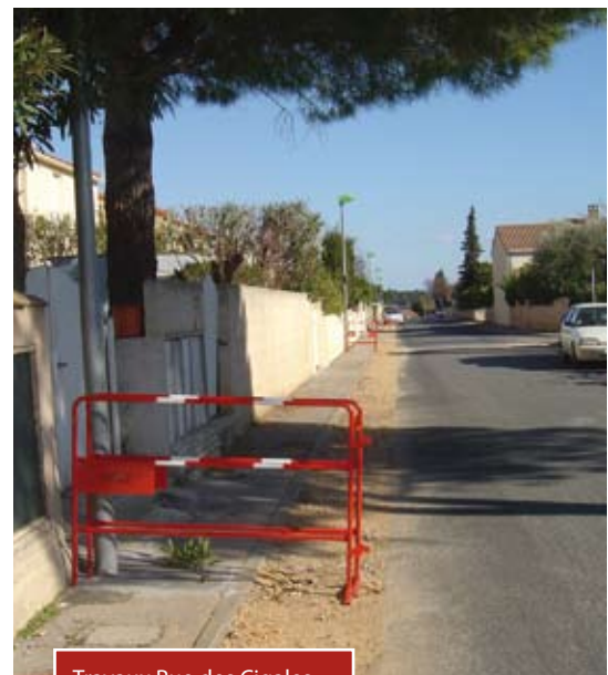
Travaux Rue des Cigales
