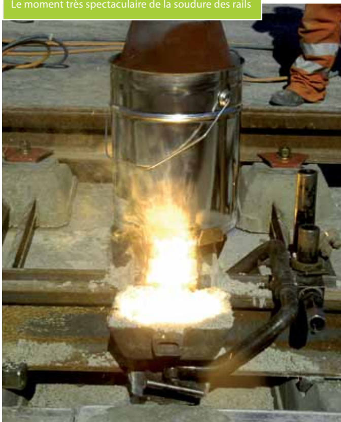
Le moment très spectaculaire de la soudure des rails
