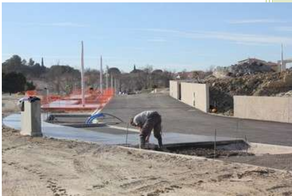
Finition de la rue de Vénus (voirie et réseaux divers, trottoirs en béton désactivé)
