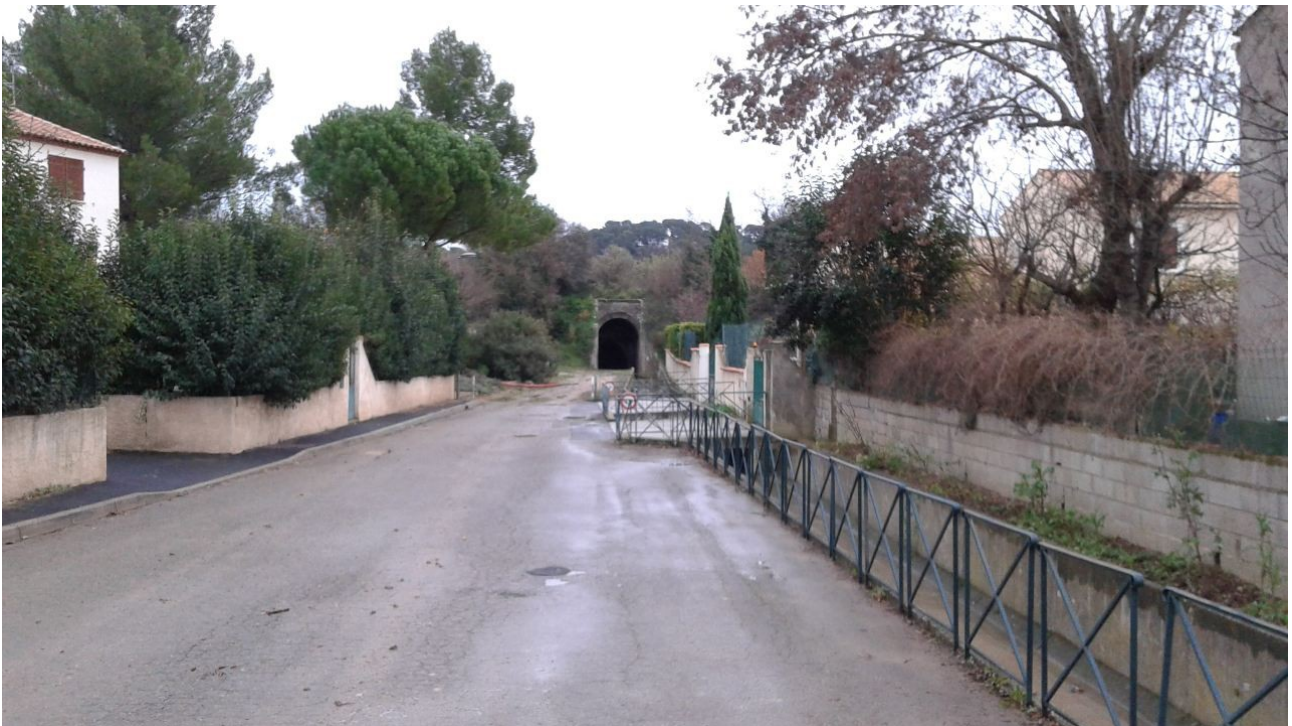
Illustration 21: Pluvial dans le quartier à l'amont de la RN109
