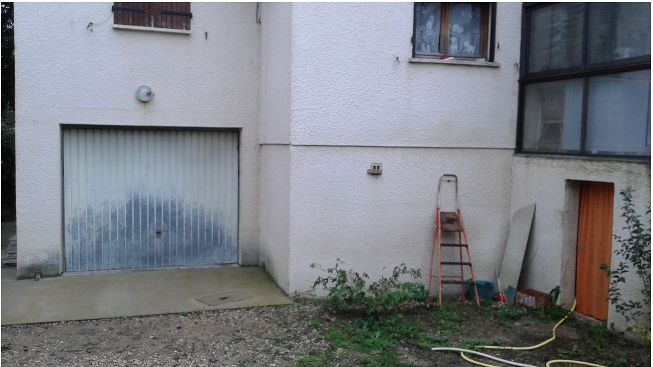
Illustration 20: Batiments dont les lieux de vie sont hauts par rapports au terrain naturel (amont de la RN109)
