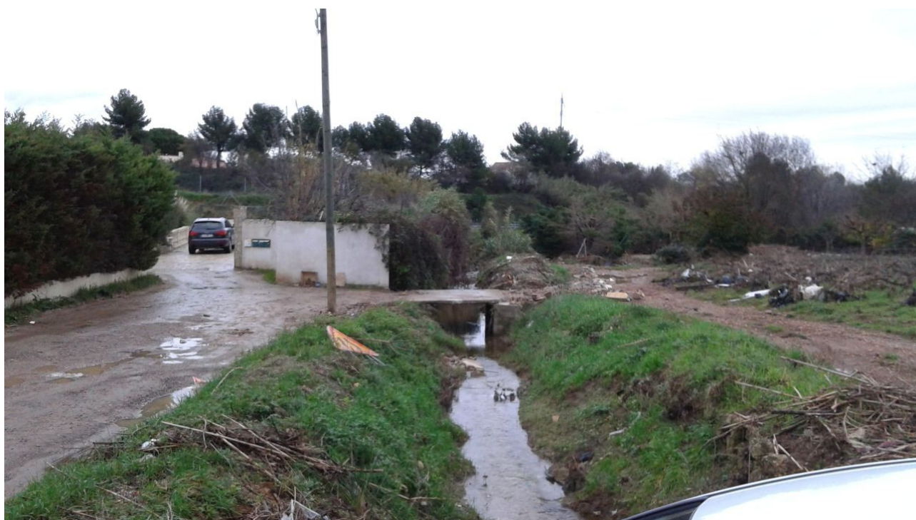
Illustration 25: Ruisseau de la Fosse (avant passage sous l'autoroute)
