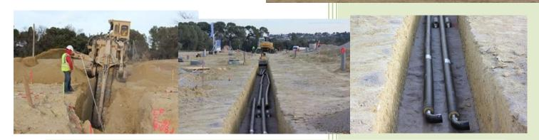
Une excavatrice en pleine action pour percer les tranchées permettant le passage du réseau de chaleur collectif (le calorifuge des tuyauteries enterrées est réalisé par des coquilles rigides de mousse de polyuréthane.
