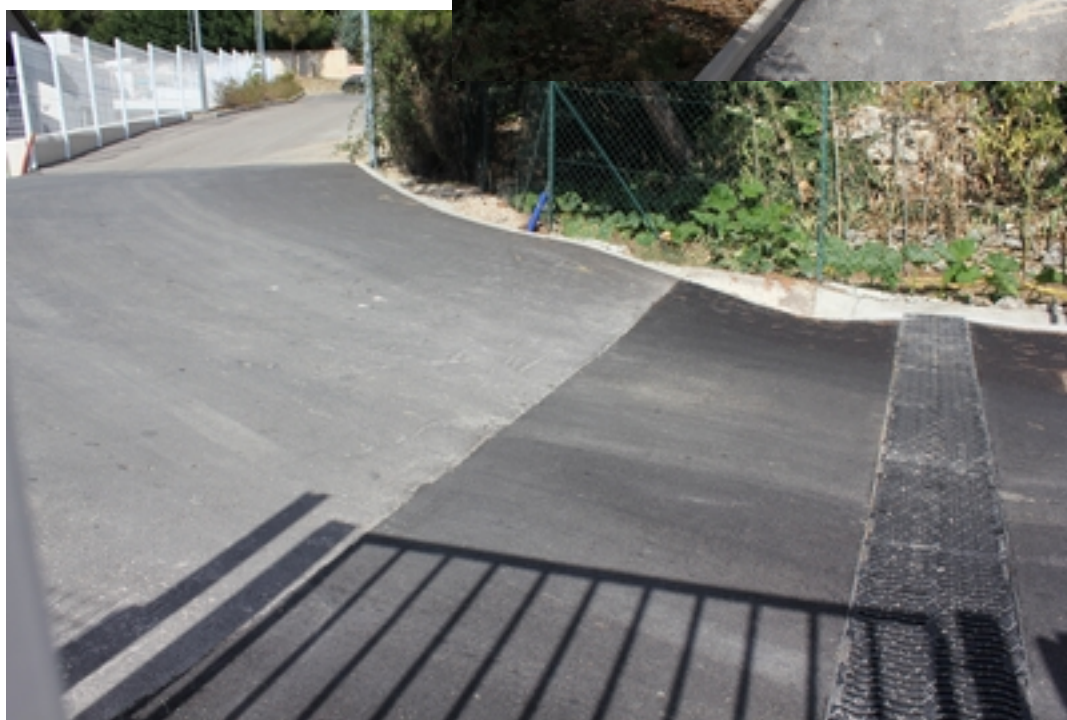
Reprise de l'entrée du site de Courpouyran (6500€)
