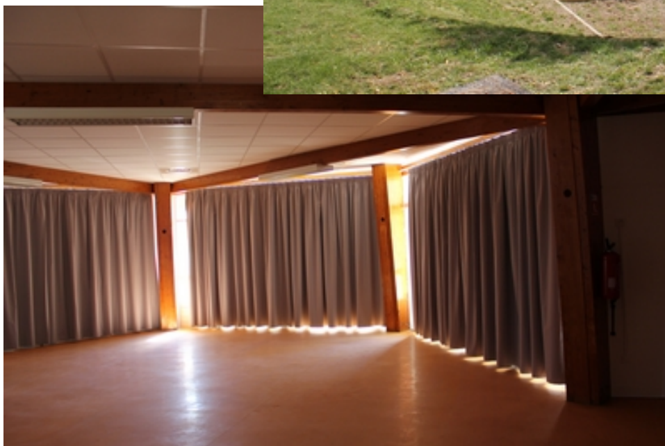
Réfection complète des différentes salles du relais (sols, faux plafonds, rideaux, peinture..) (70 000€)
