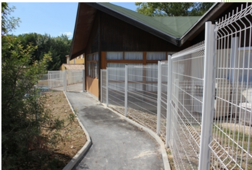
Accès PMR au relais
