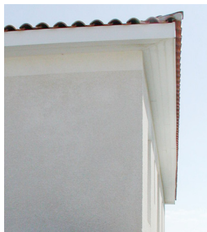
Traitement de l'évacuation des eaux pluviales et éléments de décors de façade (cheneaux, bandeaux)
