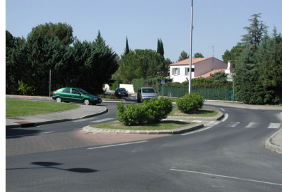
Route de Lavérune
