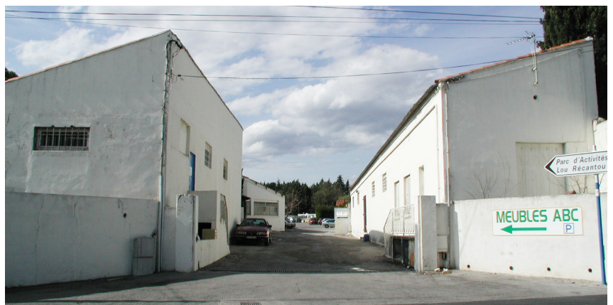
La zone d'activité est constituée de deux bâtiments se faisant face et libérant un espace central.
