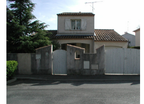
Façade orientée sur rue
