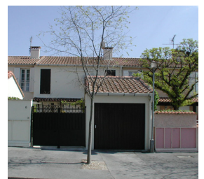
Position d'un garage
