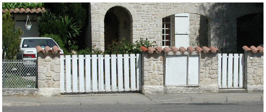
Les murs de clôtures de la Résidence de Juvignac sont tous constitués de clôtures grillagées surmontant un muret de 20 centimètres de haut et doublé par une haie. Les entrées sont toutes doubles (piétons, véhicules) et fermées par des portillons en bois peint (blanc) à lames verticales. Les éléments de raccordements aux réseaux sont intégrés dans un coffre similaire dans l'ensemble du lotissement.
