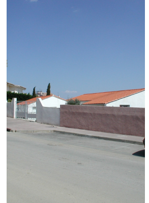
Une vue sur les toits en contrebas de l'avenue des Hauts de Font-
