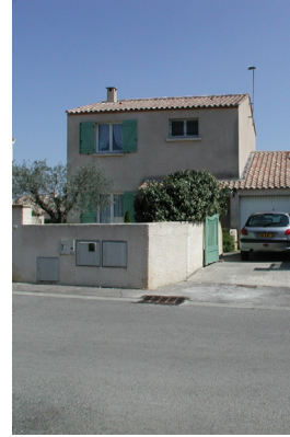
Une façade simple : logements jumelés
