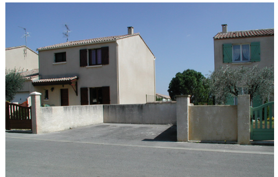
Condamnation d'entrée dans clôture
