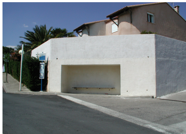
Intégration d'un abri bus dans un mur de soutènement permettant de rompre la hauteur imposante du mur.
