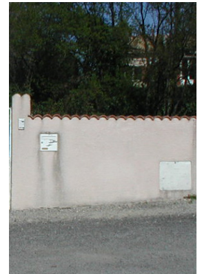
Mur de clôture maçonné
