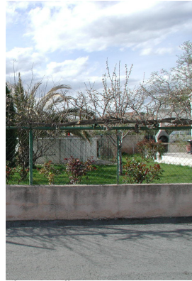
Clôture grillage + maçonnerie
