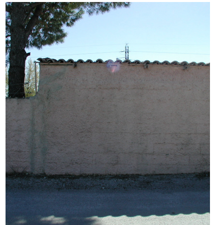
Construction annexe édifiée en limite de l'emprise publique
