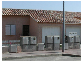
Intégration des coffres réseaux
