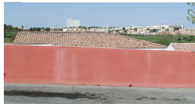
Construction à flanc de colline
