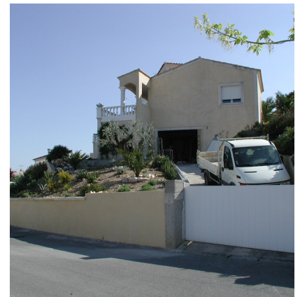
Façade pignon en négation de la rue
