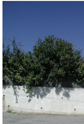
Mur de soutènement
